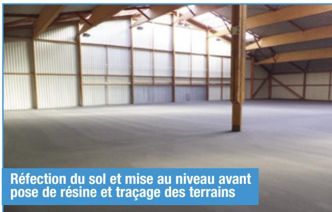
**Réfection du sol et mise au niveau avant pose de résine et traçage des terrains**
