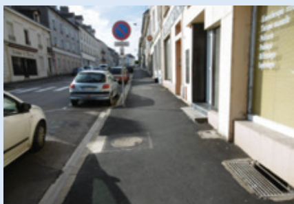
RUE JEAN JAURÈS , la réfection du trottoir a été effectuée du n° 27 au n° 9 pour un coût de 20 200 € TTC .
