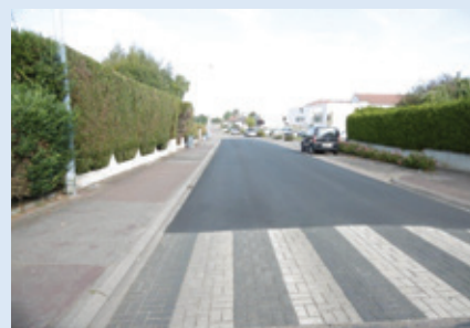
RUE EMILE ZOLA , les travaux ont porté sur la réfection de 300 m² de chaussée pour un coût de 6 700 € TTC .
