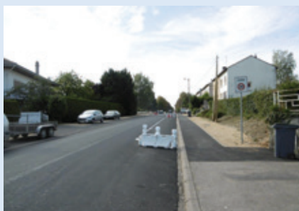
RUE DU BOIS DU FOUR , la réfection des trottoirs pairs et impairs a consisté à mettre en place un enduit coulé à froid sur la chaussée et à créer des chicanes afin de limiter la vitesse. Le coût des travaux s'élève à 61 000 € TTC pour les trottoirs pairs et impairs, 16 855 € TTC pour la chaussée et 1 000 € TTC pour les chicanes.
