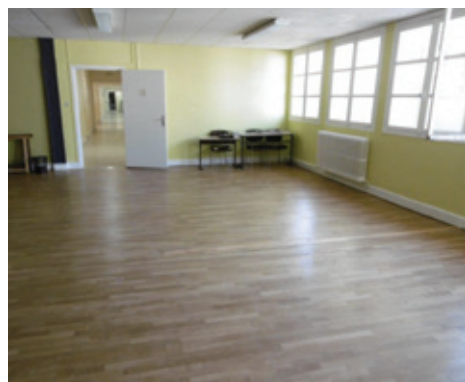
Concernant l'Ecole de Musique, la réfection des salles de musique se poursuit. Les travaux portent sur la mise en peinture, le ponçage et la vitrification des planchers. Coût pour une salle : 500 € TTC pour la peinture, hors main d'œuvre car les travaux sont réalisés en régie, 1 764 € TTC pour la vitrification du plancher.
